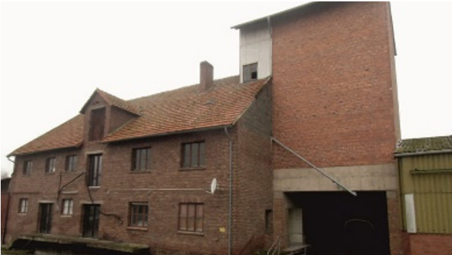
Abbildung 31: Ursprünglicher Zustand des Backsteingebäudes auf dem Gelände des REGIOwez in Eissen (Quelle: Landesverband Regionalbewegung NRW e.V.)
